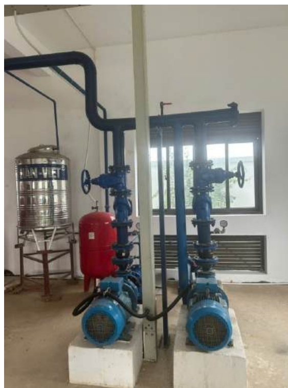
Hình 9. Hệ thống bơm tuần hoàn nước tái sử dụng
