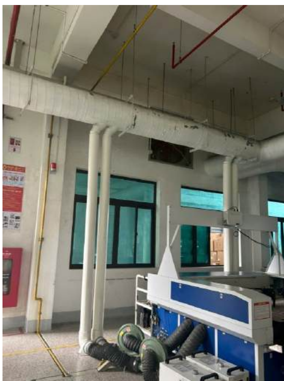
Hình 17. Hình ảnh hệ thống xử lý khí thải tại xưởng 3
