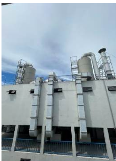
Hình 19. Hình ảnh về hệ thống xử lý khí thải công đoạn cắt laser tại xưởng 5
