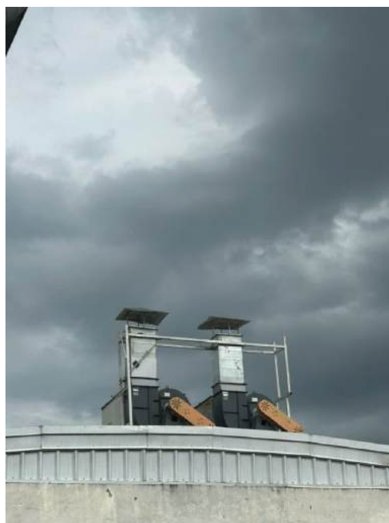
Hình 17. Hình ảnh hệ thống xử lý khí thải tại xưởng 3
