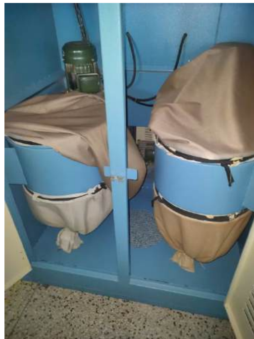
Hình 22. Hình ảnh thiết bị lọc bụi túi vải
