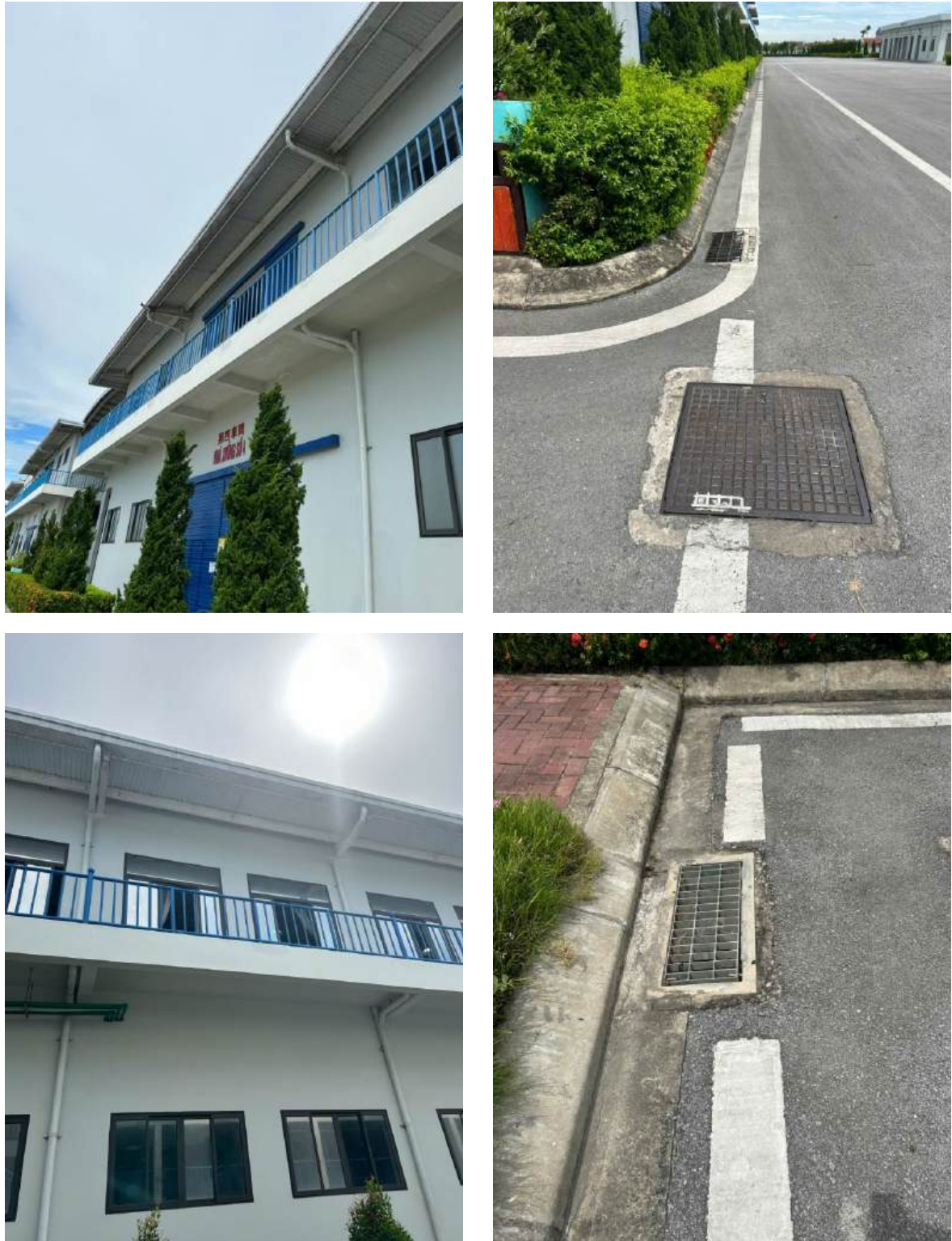
Hình 7. Hình ảnh thoát nước mưa trong nhà máy
