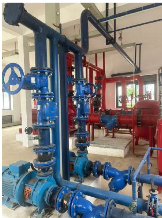
Hình 9. Hệ thống bơm tuần hoàn nước tái sử dụng
