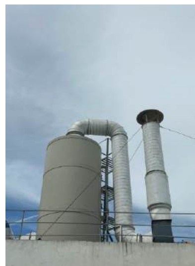
Hình 19. Hình ảnh về hệ thống xử lý khí thải công đoạn cắt laser tại xưởng 5
