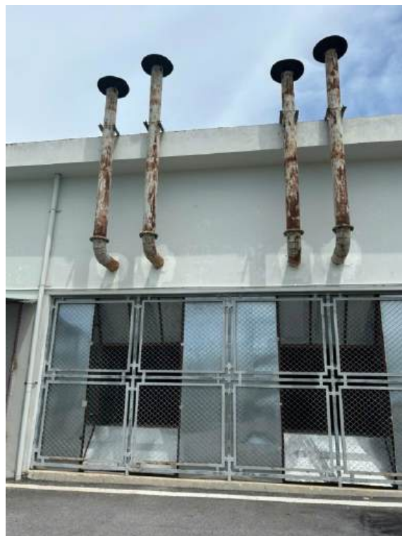
Hình 25. Hình ảnh thoát khí máy phát điện
