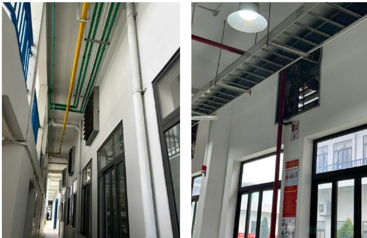
Hình 24. Hình ảnh lắp đặt quạt công nghiệp bên trong nhà xưởng sản xuất
