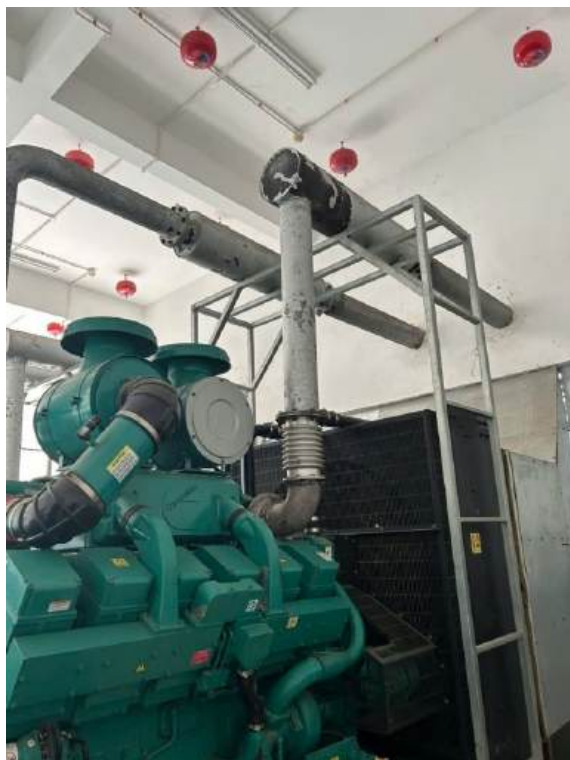
Hình 25. Hình ảnh thoát khí máy phát điện
