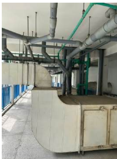
Hình 19. Hình ảnh về hệ thống xử lý khí thải công đoạn cắt laser tại xưởng 5
