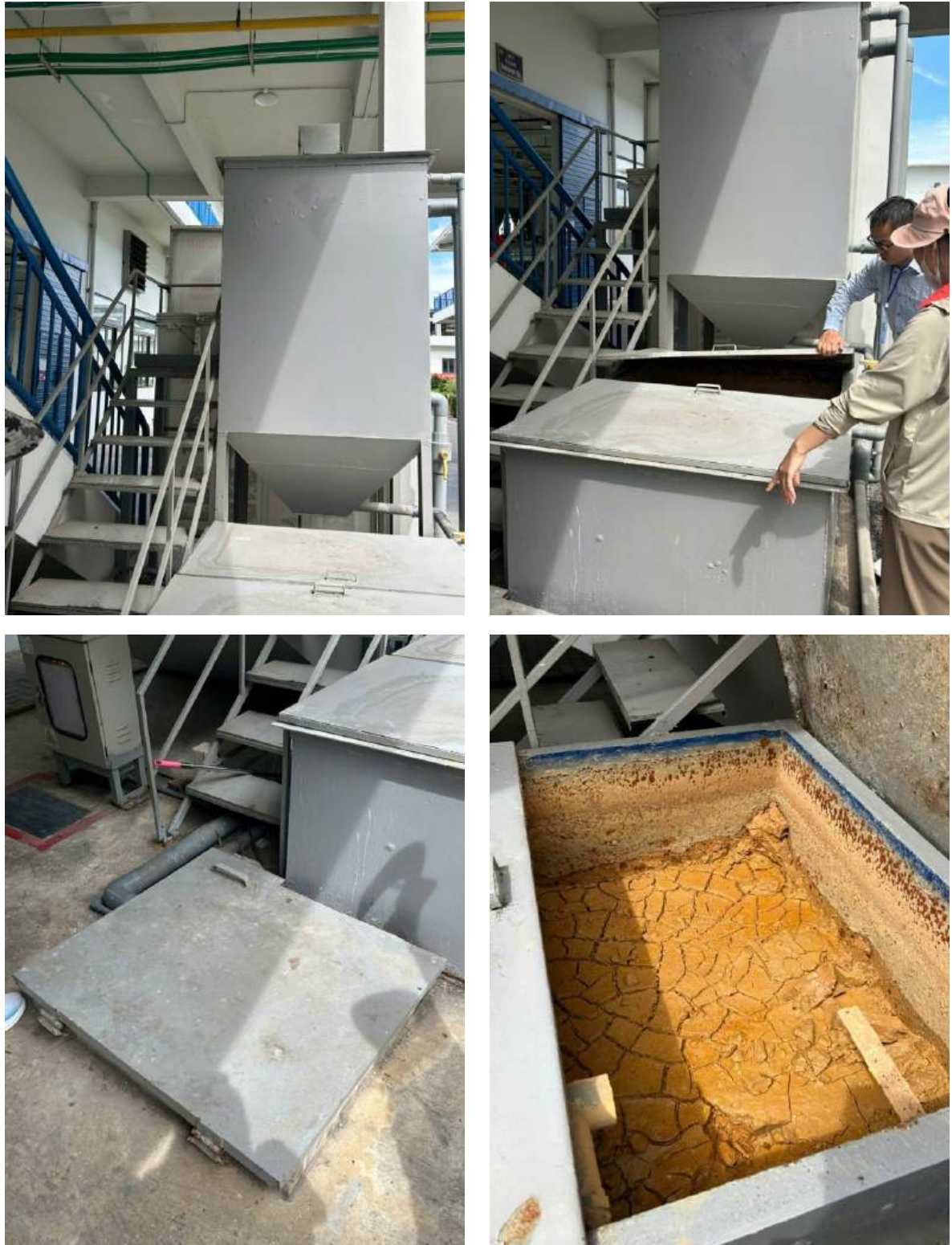
Hình 13. Hệ thống xử lý nước thải sản xuất của nhà máy
